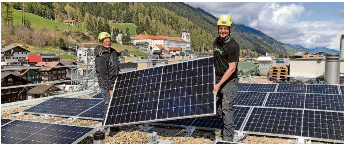
Ils moduls da fotovoltaica vegnan installai sil tetg da Puntreis.
